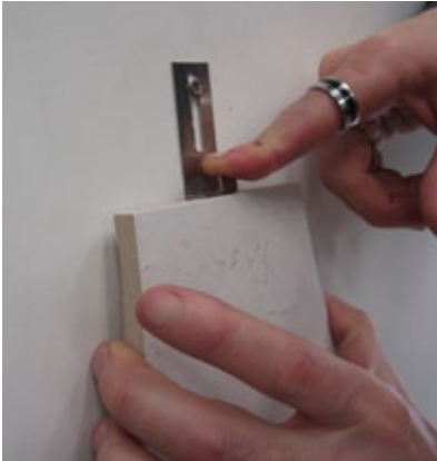
Fix the middle staple in the groove. Ajustar grapa de continuación en la ranura
