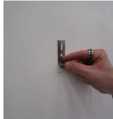
Middle anchorage to be fixed after the tile has been placed. Posibilidad de ajustar la posición del anclaje después de colocar la pieza
