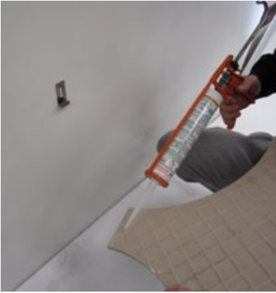
Place polyurethane sealant. Poner masilla de poliuretano
