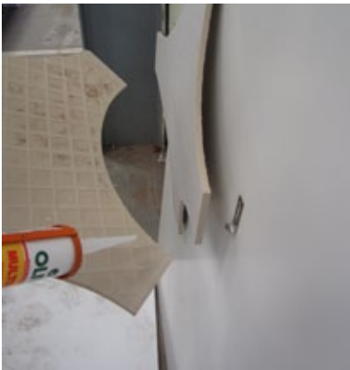
Fix the middle staple in the groove. Ajustar grapa de continuación en la ranura
