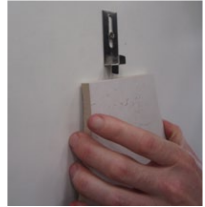
Insert upper part of the piece. Ajustar parte superior de la pieza
