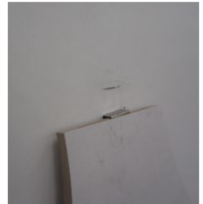
Adjust staple to fix the last piece. Ajustar posición grapa a la pieza
