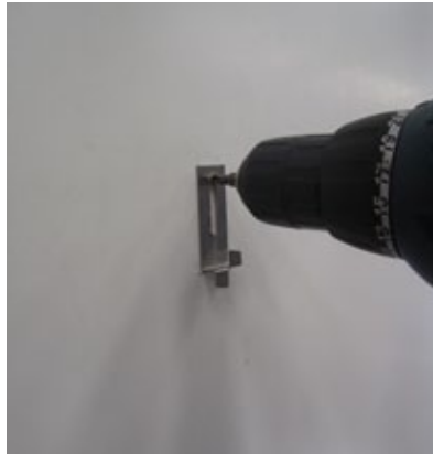
Middle anchorage example. Ejemplo anclaje continuación
