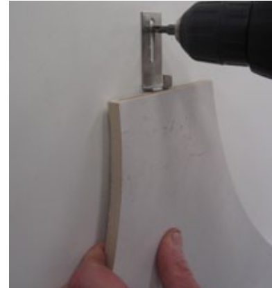
Fix the screw completely. Apretar el tornillo completamente.
