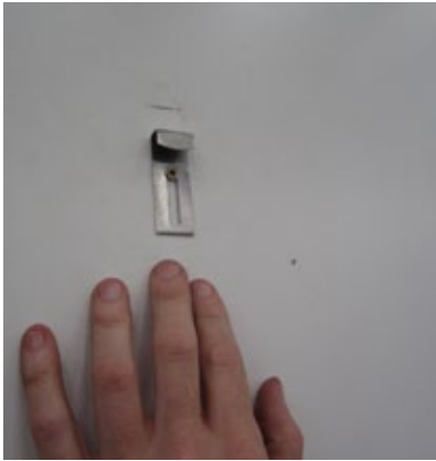
Ending anchorage example. Ejemplo anclaje de finalización
